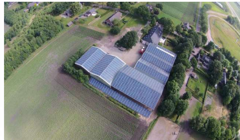
屋根設置事例
