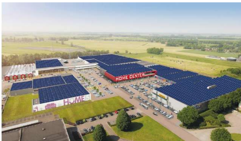
屋根設置事例
