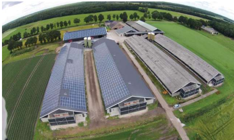
屋根設置事例
